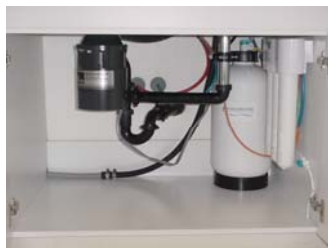
EWA BEACH (Kula Lei) Installed 7/13/05
